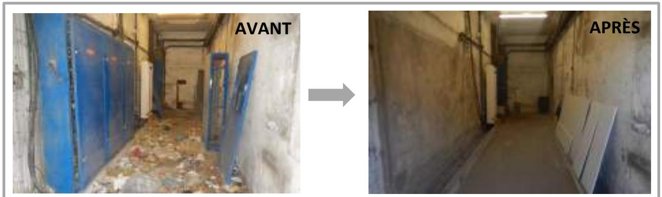
*Retrait des armoires électriques obsolètes et du réseau électrique hors d'usage au niveau du local Tableau Général Basse Tension (TGBT)*
